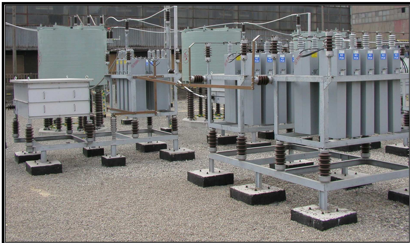
Automatycznie regulowana instalacja kompensacji mocy biernej pieca łukowego Filtr 2-giej harmonicznej typu „C” o mocy 46MVar/38,5kV. Realizacja Elma energia
